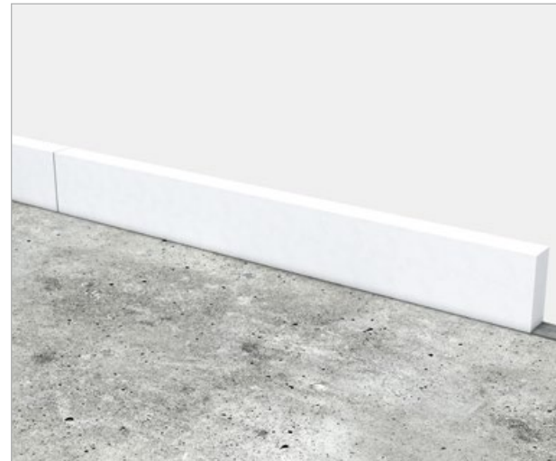
2. Montage der ersten Lage MBT in die Mörtel- ausgleichsschicht
